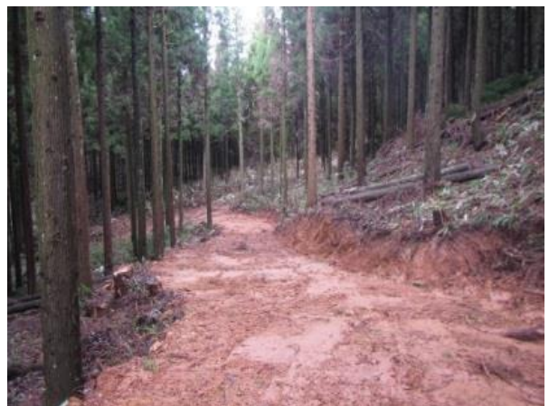
林業機械が走行するため新たに開設した作業道 (最低3m程度の幅が必要となります。)
